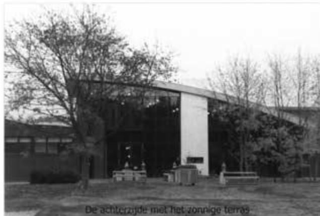
De achterzijde met het zonnige terras
