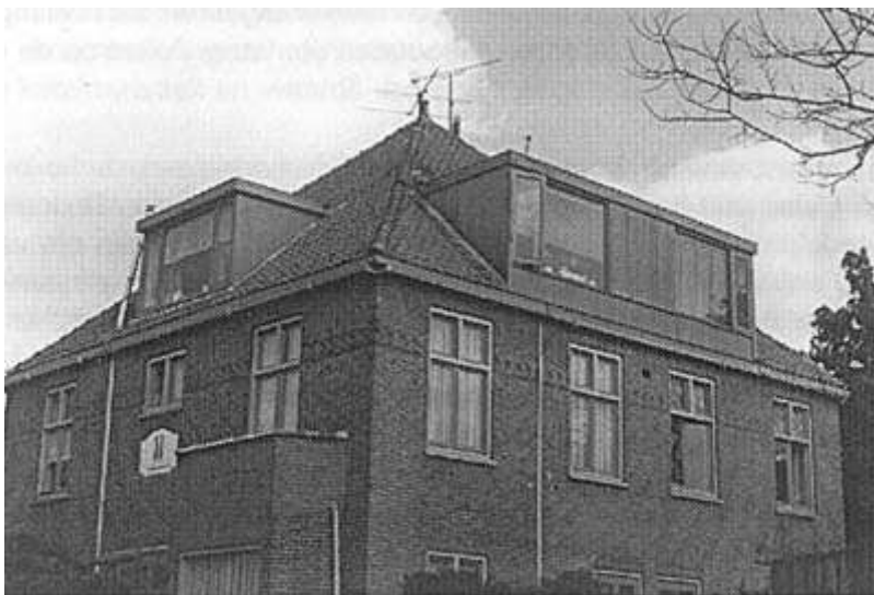
Deze dakkapellen zijn veel te groot. afgestemd op de bestaande bebouwing.
