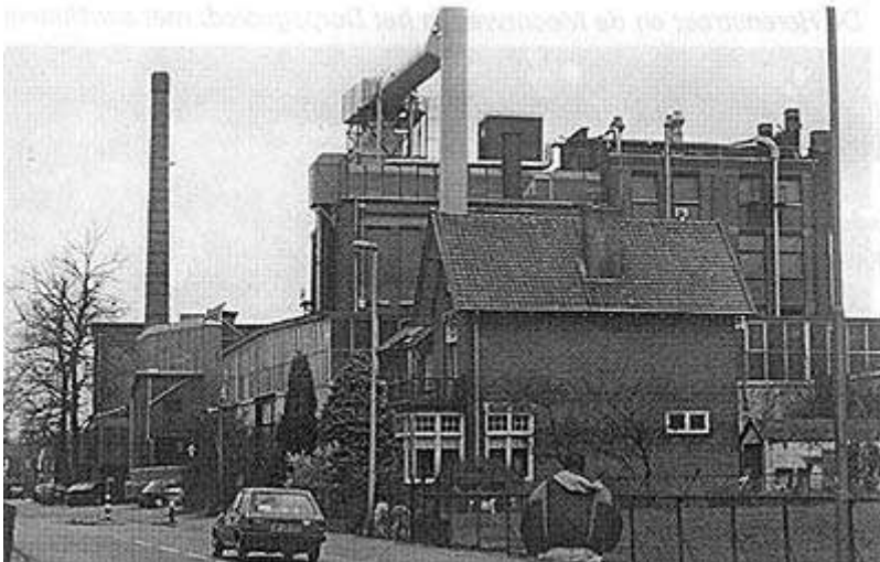
De fabriek van Bendsdorp bepaalt met zijn schoorstenen en bouwhoogte voor een belangrijk deel het ruimtelijk beeld van de Spoorzone.
